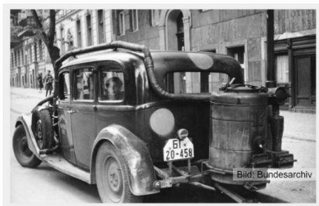
Abb. 9: Auto Anfang der 1950er Jahre mit Holzvergaseranlage.
